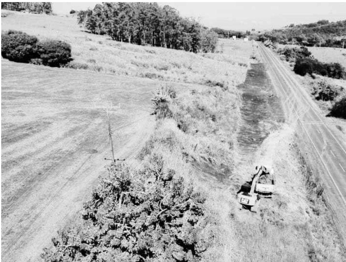
Área comprada possui 3 hectares e fica localizada a 2KM do município tavorense, às margens da PR 218, sentido Carlópolis
